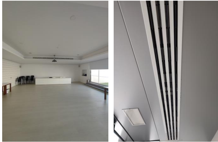
Figura 17: Rejillas finales de difusión
