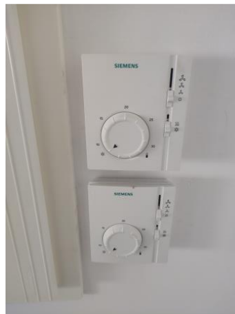
Figura 18: Termostatos
